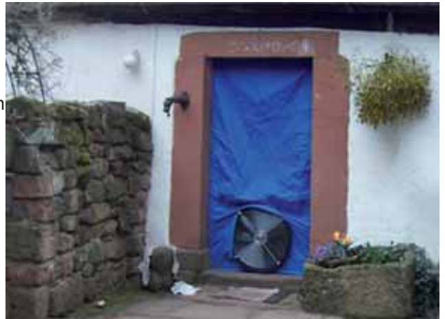
Gebäudeeingangstür eines Altbaus bei der Blower-Door-Messung
